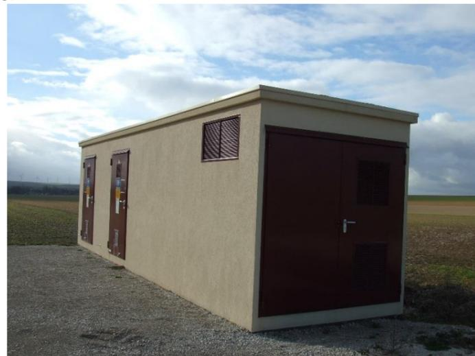
Figure 12 : Illustration du poste de livraison du parc éolien de Martinpuich / Le Sars (source : Nordex, 2013)
